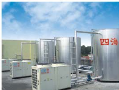
空气能热水器工程现场
